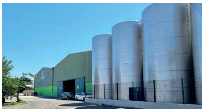
Los depósitos exteriores pueden almacenar hasta 150.000 litros cada uno
